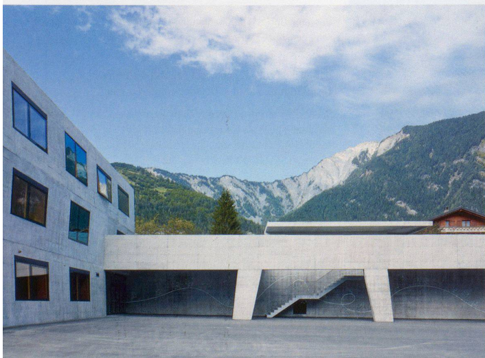
Ansicht von der tiefer liegenden Esplanade, Schulhaus und Verbindungsbau
