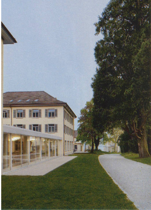
Nordfassade mit neu in den Osthof eingebautem Speisesaal (oben); Bistro mit aufwändigen Holzarbeiten (Mitte) und neues Haupttreppenhaus mit Blick in den Korridor im 1. Obergeschoss
