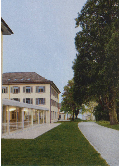
Nordfassade mit neu in den Osthof eingebautem Speisesaal (oben); Bistro mit aufwändigen Holzarbeiten (Mitte) und neues Haupttreppenhaus mit Blick in den Korridor im 1. Obergeschoss
