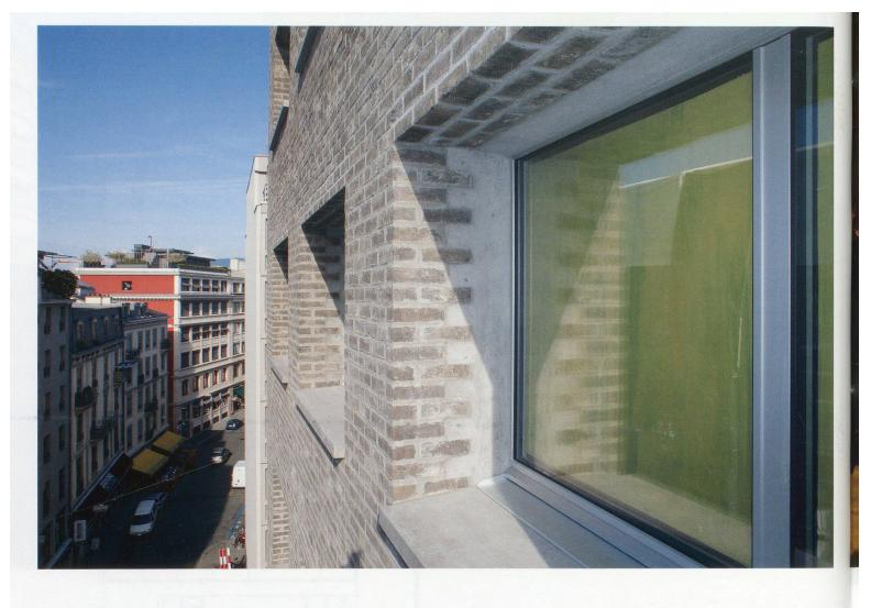
Der Fassadenklinker berührt die Fenster nicht; den Übergang zwischen Backstein und Rahmen bildet eine Schicht Wärmedämmputz.
