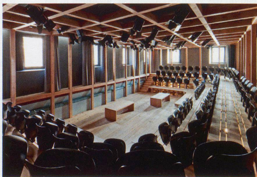
Lärchenholzgerüst als Theater-Einbau im ehemaligen Schwimmbad (rechts), Estrade als mögliche Erweiterung des Bühnenraums (links) und Foyer mit inszenierten Rohrleitungen (unten)
