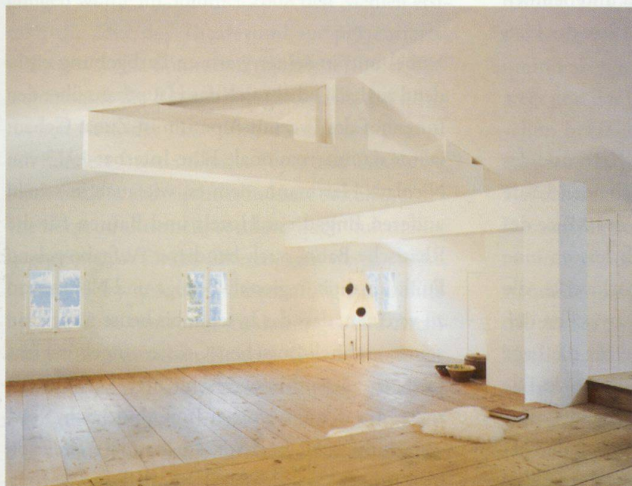
Dachgeschoss der Chesa Gabriel mit neuer Tragstruktur
