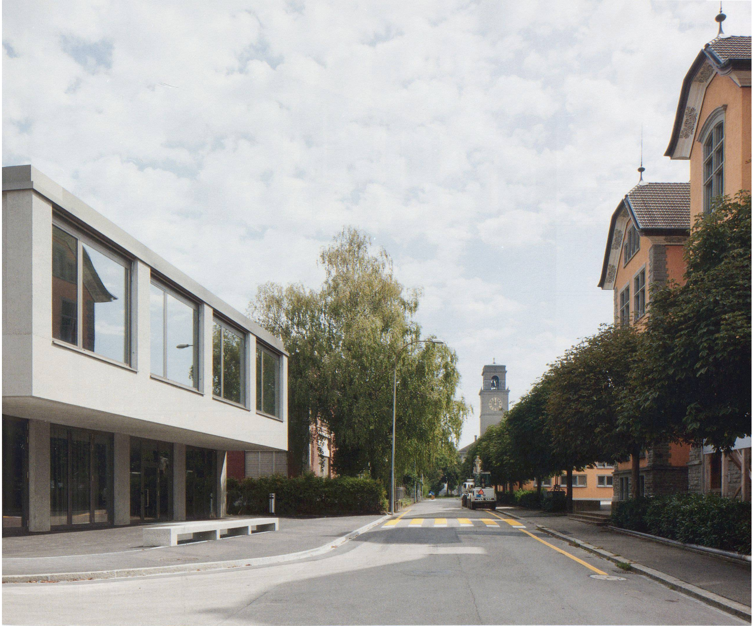
Blick in die Thomas-Bornhauserstrasse mit der Sântishalle links und dem bestehenden Schulhaus Bergli rechts
