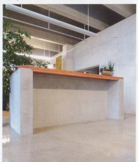
${\bf B\"{u}roarbeits platz\ mit\ direkt\ in\ die\ Tragstruktur\ eingelassenen\ Tablaren}$
