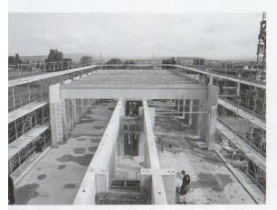
Aufbau der Tragstruktur auf der Baustelle (oben); zwei Längsträger bilden eine raumhaltige Wand (rechts). – Bilder: Käferstein & Meister
