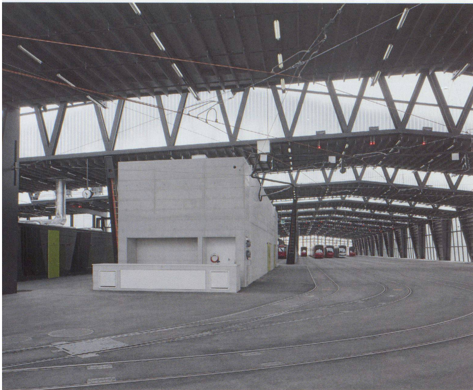
Blick durch die ganze Länge der Abstellhalle
