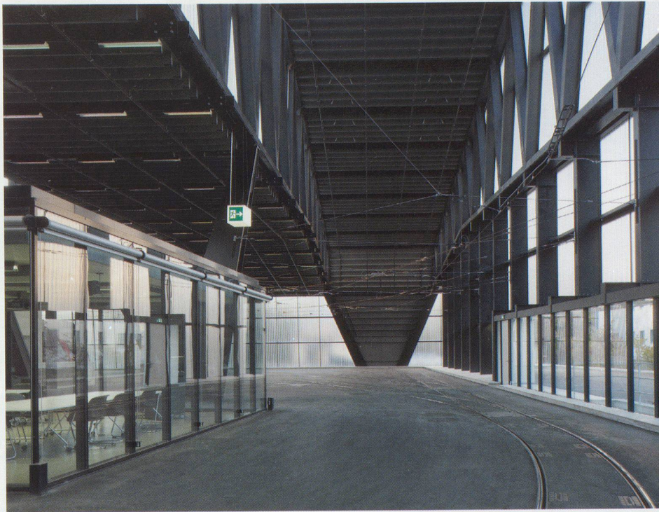
Wendeschleife im hinteren Teil des Depots; bei einer Erweiterung der Werkstatt fällt die Fassade rechts weg.
