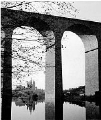
Reichsautobahnbrücke bei Limburg, 1938–40
