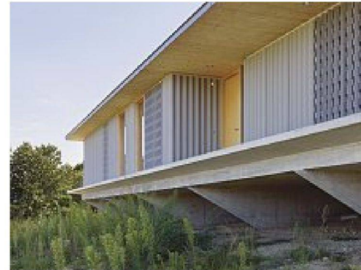
Nordostfassade mit perforiertem Eternit
