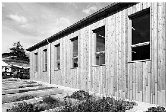
Faserzementplatten ersetzen den Sockel
