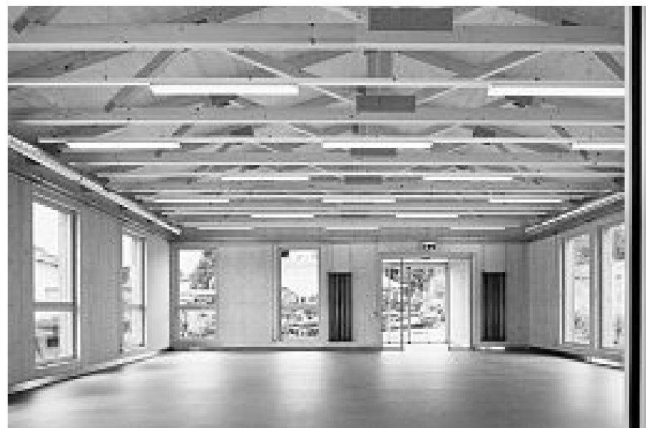
Verkaufsraum mit Nagelplattenbindern
