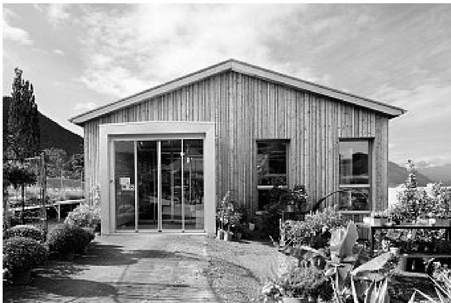
Schlichte Architektursprache, raffinierte Fassade
