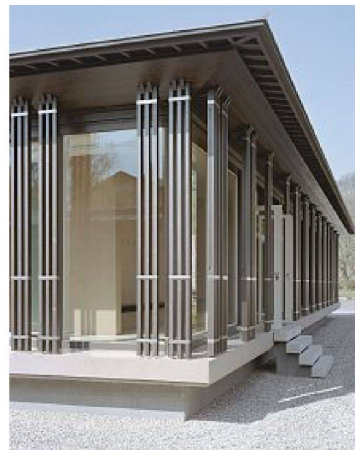
Holzlamellen als Sicht- und Sonnenschutz
