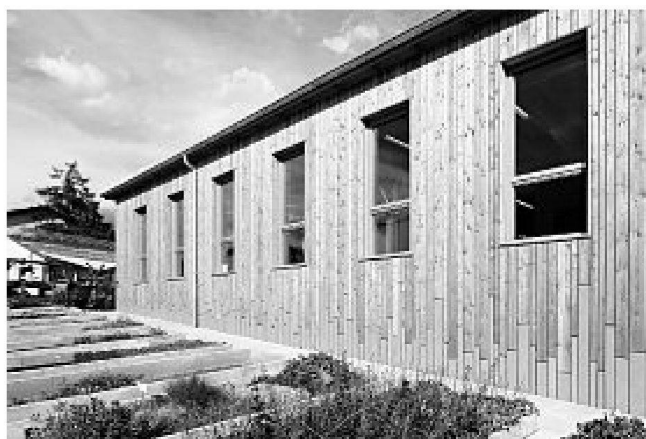
Faserzementplatten ersetzen den Sockel
