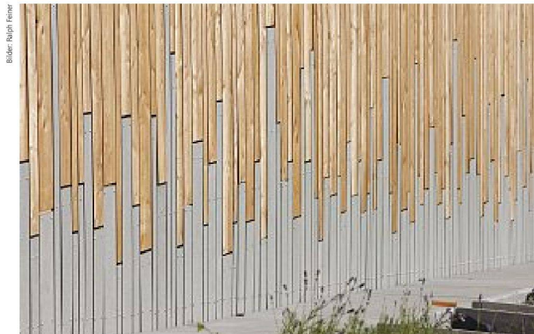
Faserzementplatten und Lärchenholzplatten am Sockelübergang
