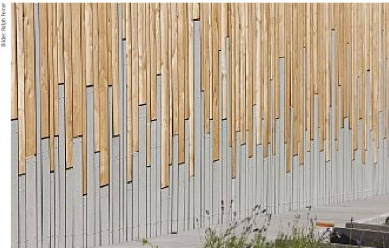
Faserzementplatten und Lärchenholzplatten am Sockelübergang
