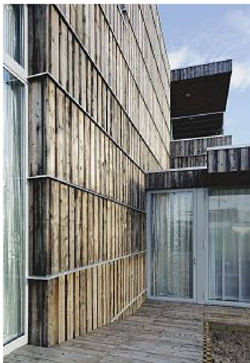
Villa Welpeloo, Fassade aus Holz von alten Kabelrollen (links); Innenraum (oben)
