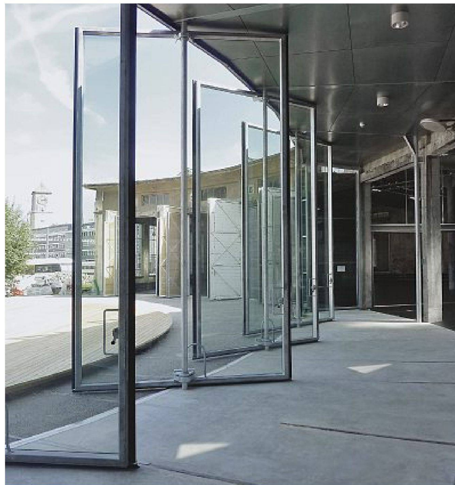
Oben: Zugang vom Badhaus her. – Bild: Katalin Deer. Unten: Die gläserne «Sichel» bildet den neuen gemeinsamen Zugang für alle Institutionen im Haus. – Bild: Stürm & Wolf Architekten
