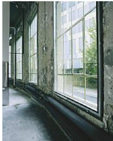
Oben: Aufdoppelung der Fenster mit grossen, beweglichen Glasplatten. – Bild: Stürm & Wolf Architekten. Rechts: Ausstellungsraum des Kunstmuseums mit Installation von John Armleder. – Bild: Stefan Rohner
