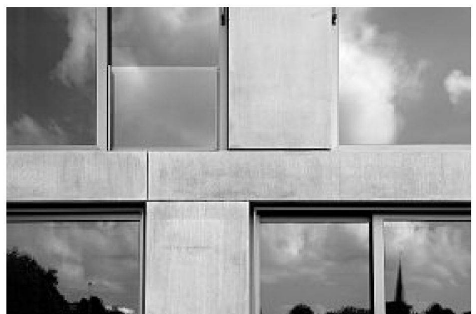
Vorfabrizierte Fassadenelemente aus Beton
