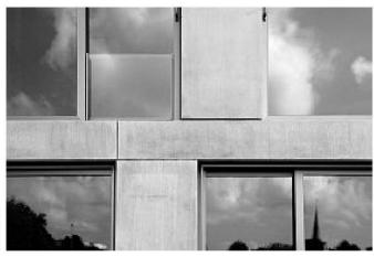
Vorfabrizierte Fassadenelemente aus Beton
