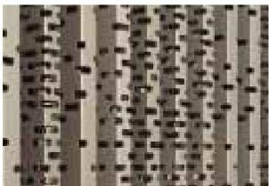
und schwarz einbrennlackiert. Auch die Wetterschutzfolie ist schwarz, so dass die optische Wirkung unter der durchbrochenen Fassade einheitlich ist.
