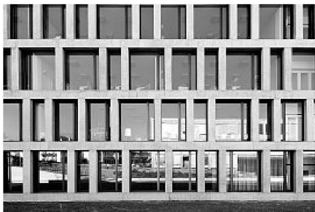
Trame en béton avec trois formats de fenêtres différents
