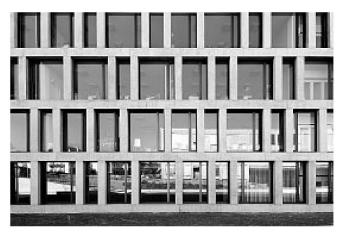
Trame en béton avec trois formats de fenêtres différents
