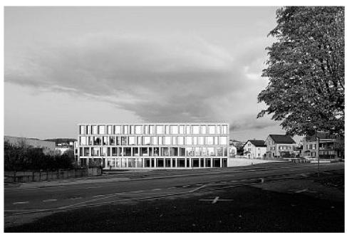
Façade porteuse en béton armé
