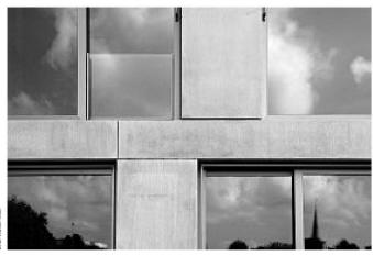
Vorfabrizierte Fassadenelemente aus Beton
