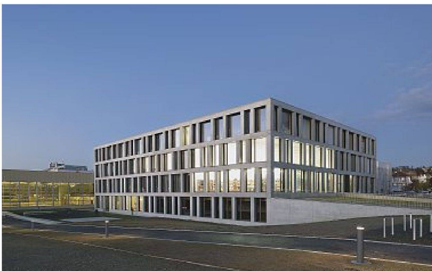
Collège du Léman in Renens von Esposito & Javet Architectes
