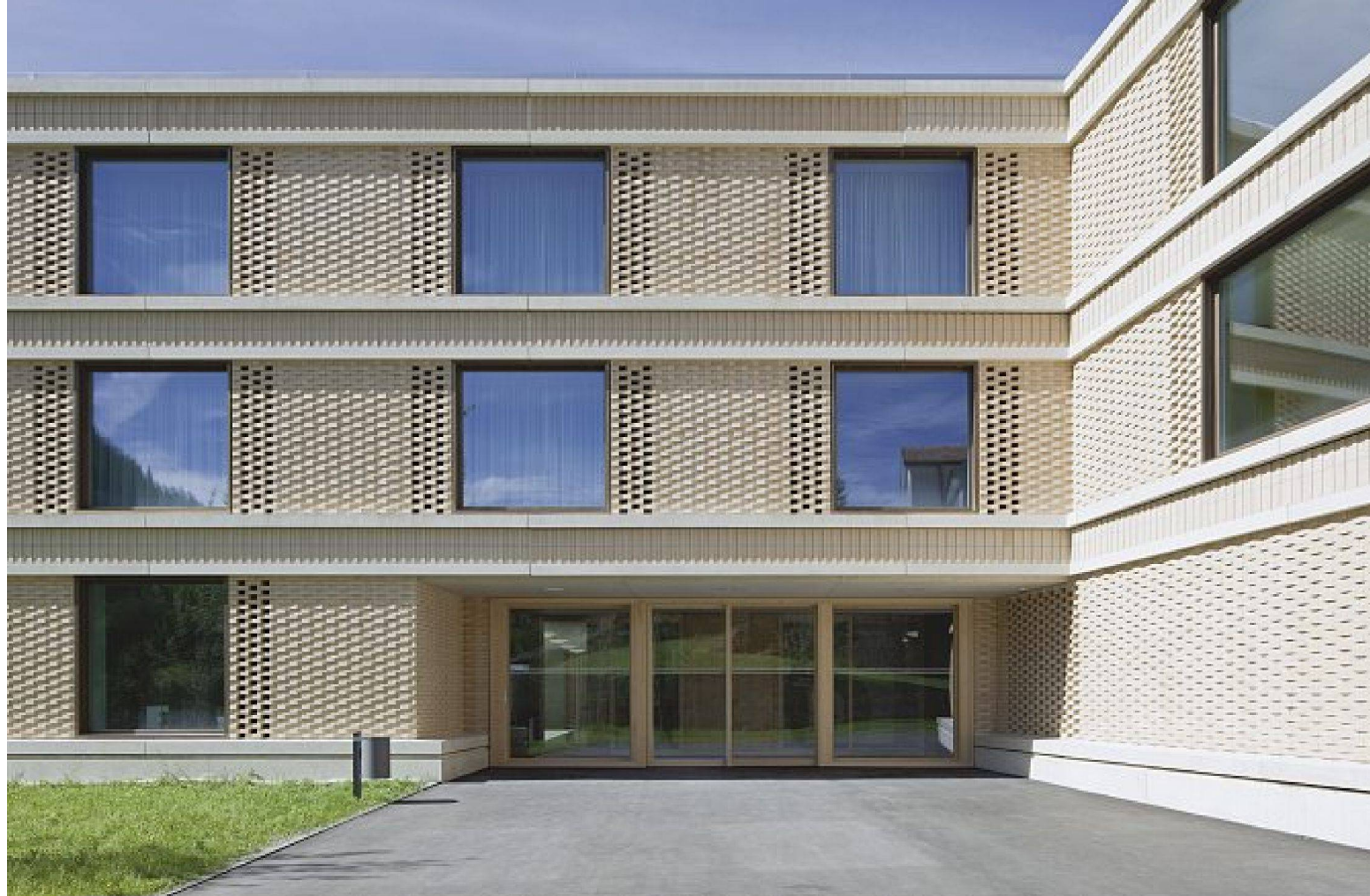
Eingangsbereich an der Ostfassade. – Bild: Beat Bühler
