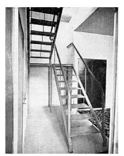
Treppe im Pavillon de l'Esprit Nouveau, ausgeführt durch «La Construction Tubulaire Soudée». – Bild aus: Le Corbusier, Vers une Architecture, Les Editions G. Crès et Cie, Paris 1924.
