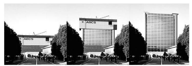
Automatisierte Baustelle in Japan, Bauverlauf der ABCS (Automated Building Construction Systems). - Bild aus: M. Eidenbenz, P. Filipaj und S. Menz (Hrsg.), Changes, VDF Hochschulverlag, Zürich 2010.
