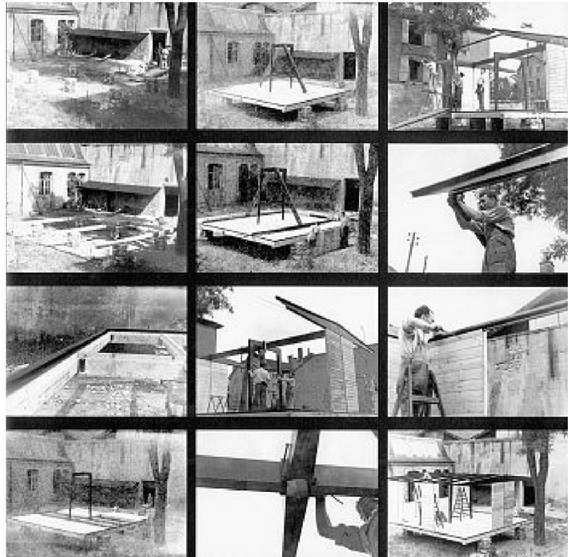
Jean Prouvé: Montage des Prototypen eines Hauses 6 x 6 für Kriegsgeschädigte, 1944–45 auf dem Gelände der Werkstatt in der Rue des Jardiniers in Nancy. – Bild aus: A. von Vegesack (Hrsg.), Jean Prouvé, Die Poetik des technischen Objekts, Vitra Design Stiftung, Weil am Rhein 2006.
