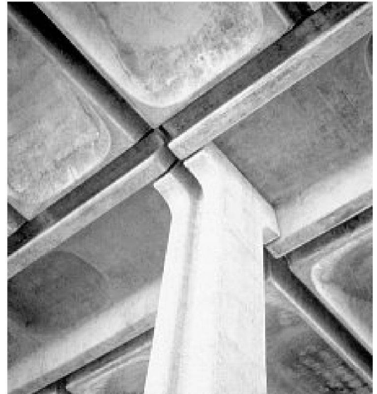
Bausystem U70 Isocell von Angelo Mangiarotti, Brianza / Como, 1969. – Bild aus: Uta Hassler und Hartwig Schmidt (Hrsg.), Häuser aus Beton, Wasmuth Verlag, Tübingen und Berlin 2004.
