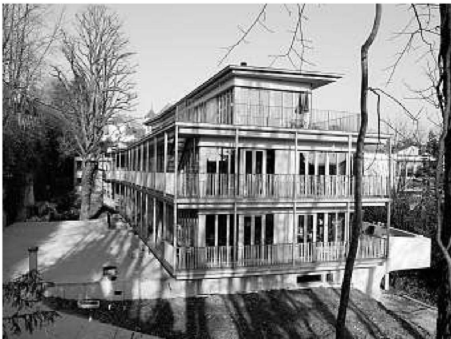
Holzständerbauweise auf betoniertem Sockel
