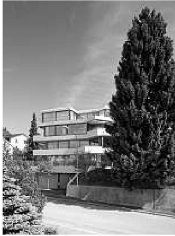
Ansicht von der Segantinistrasse
