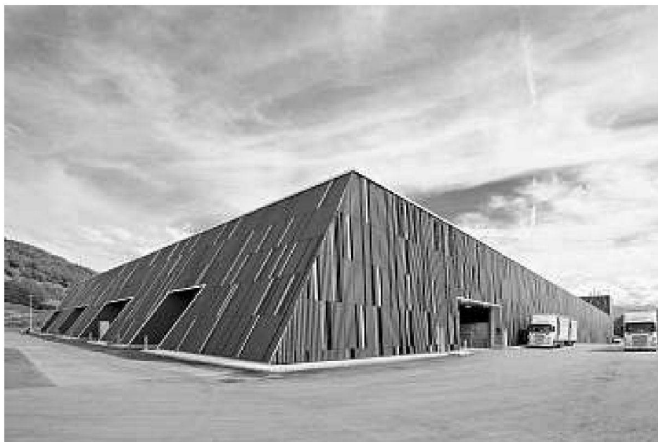
Ansicht von Norden mit geschützten Verladerampen
