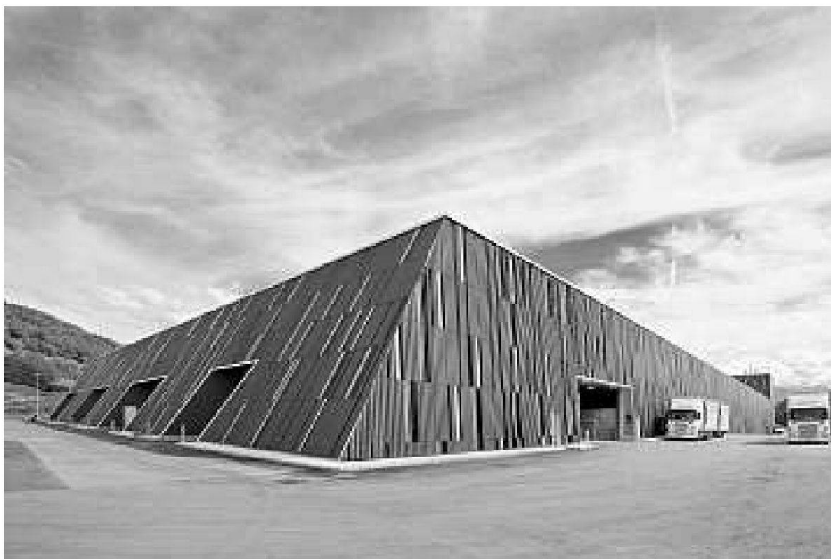
Ansicht von Norden mit geschützten Verladerampen
