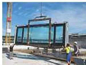
Als Grundlage für sämtliche, bis 600 kg schweren Fensterelemente, die von der Surber Metallbau AG geliefert wurden, diente das hoch dämmende Reynaers Fenster- und Türsystem CS 86-HI. Das thermisch isolierte 3-Kammersystem ist flexibel einsetzbar, verbindet gutes Design mit optimaler Stabilität und bietet mit Uf-Werten von bis zu 1,4 w/m K zugleich höchste Wärmedämmung. Reynaers AG Aluminium Systeme CH-8500 Frauenfeld
