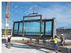
Als Grundlage für sämtliche, bis 600 kg schweren Fensterelemente, die von der Surber Metallbau AG geliefert wurden, diente das hoch dämmende Reynaers Fenster- und Türsystem CS 86-HI. Das thermisch isolierte 3-Kammersystem ist flexibel einsetzbar, verbindet gutes Design mit optimaler Stabilität und bietet mit Uf-Werten von bis zu 1,4 w/m K zugleich höchste Wärmedämmung.
