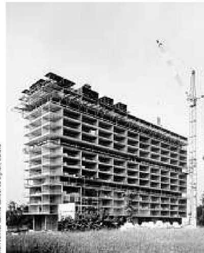
Rohbau mit stählerner Tunnelschalung, 1966
