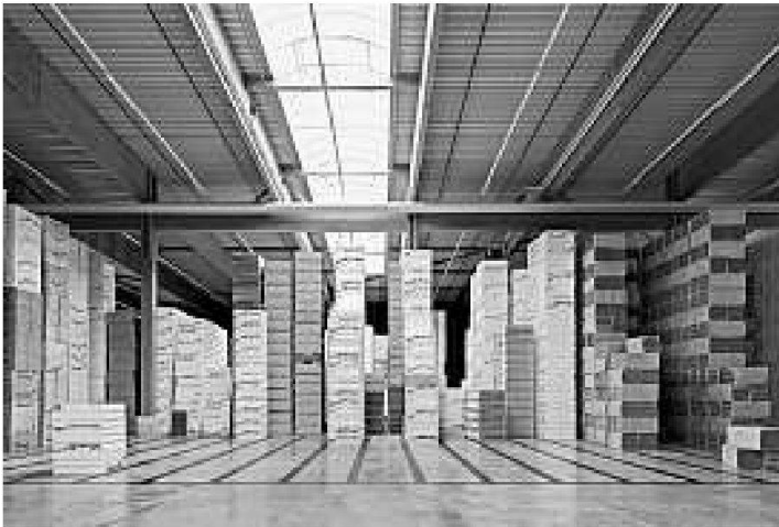
Lagerhalle für Dämmstoffprodukte
