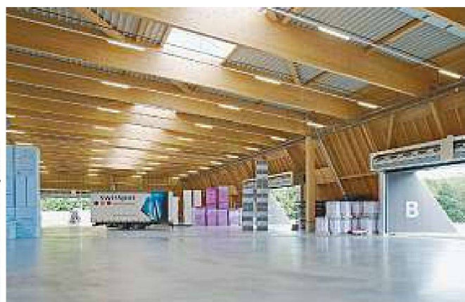
Inneres der Halle mit hölzernem Tragwerk
