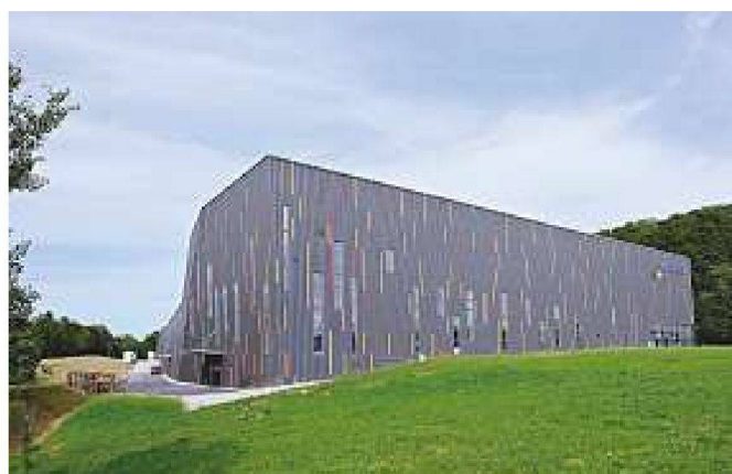
Swisspor Betriebsgebäude, Aussenansicht von Süden
