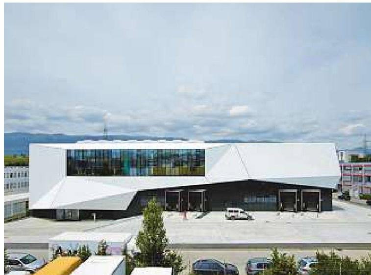
Eine weisse LKW-Plane umhüllt das Logistikzentrum
