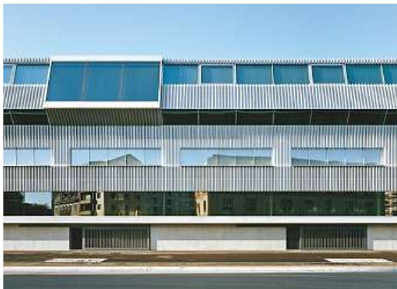
Nahaufnahme und Ausschnitt Fassade: Einblick in die Konstruktion und funktionale Logik
