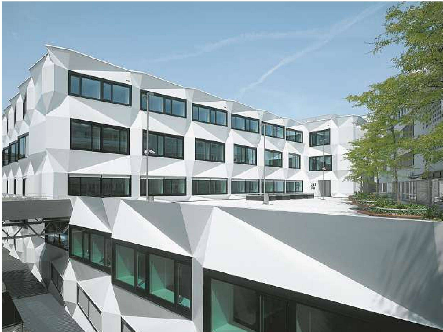
Südseitiger Innenhof. – Bild: Roger Frei
