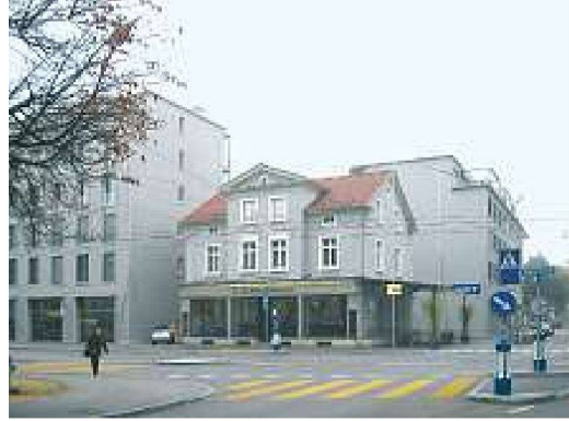
Bild: Amt für Städtebau, 2006, kurz vor Abbruch
