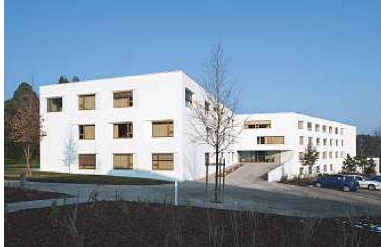
Tiefe Lochfenster sollen den öffentlichen Charakter betonen.
