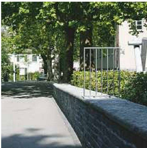
Normierung ad absurdum: Ab einer Höhe von 80 cm müssen Bauteile gemäss der SIA Norm 358 «Geländer und Brüstungen» gegen die Gefahr eines Absturzes gesichert werden; beim Schulhaus Milchbuck in Zürich gilt dies auch für eine Stützmauer, die als Sitzgelegenheit vor gut 80 Jahren entworfen, entlang eines abfallenden Wegs immer höher wird. – Bild: Tibor Joanelly
