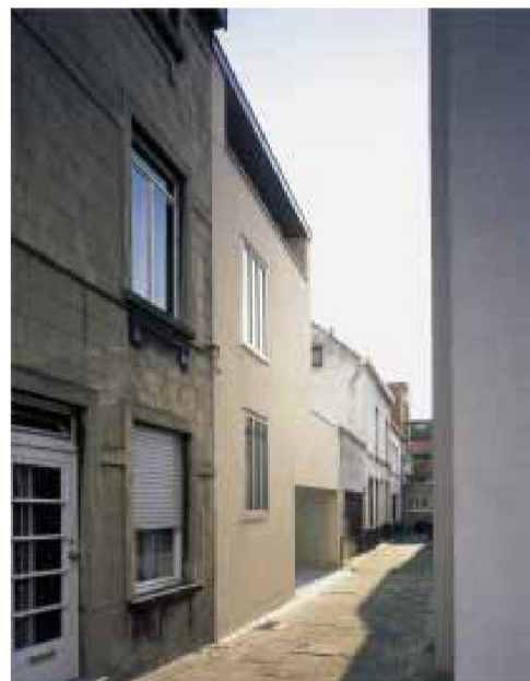
Aussenansicht von der Gasse aus
