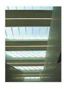
die eine Pfosten-Riegelkonstruktion für grossflächige Schräg- und Dachverglasungen trägt. Dieses System ermöglicht eine zuverlässige Dichtung bei kontrollierter Belüftung und Entwässerung an den Glasfalzen. Weil die Zargen auf die äusseren Ränder der Betonbrüstungen gesetzt sind, ist die Rahmenkonstruktion von innen praktisch unsichtbar. Die Lüftungsflügel sind in das Rahmensystem der Oberlichter integriert, ihre Antriebe verdeckt eingebaut.
