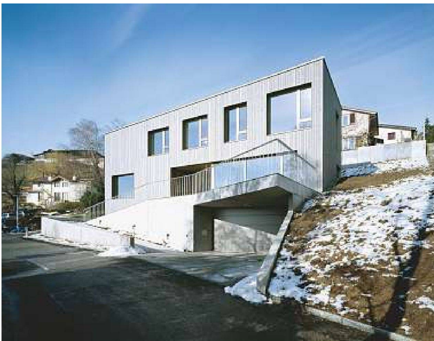
Das Haus hat sich mit der Strasse versöhnt.
