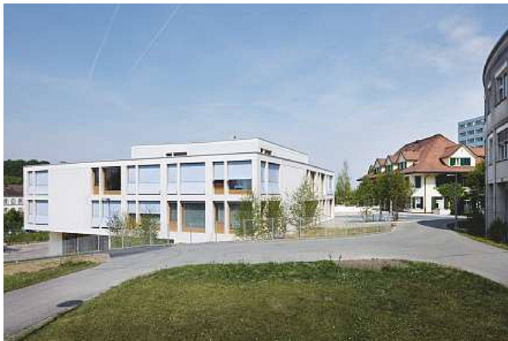
Auf der oberen Ebene fügt sich das Volumen in die Reihe der benachbarten Bauten ein.
