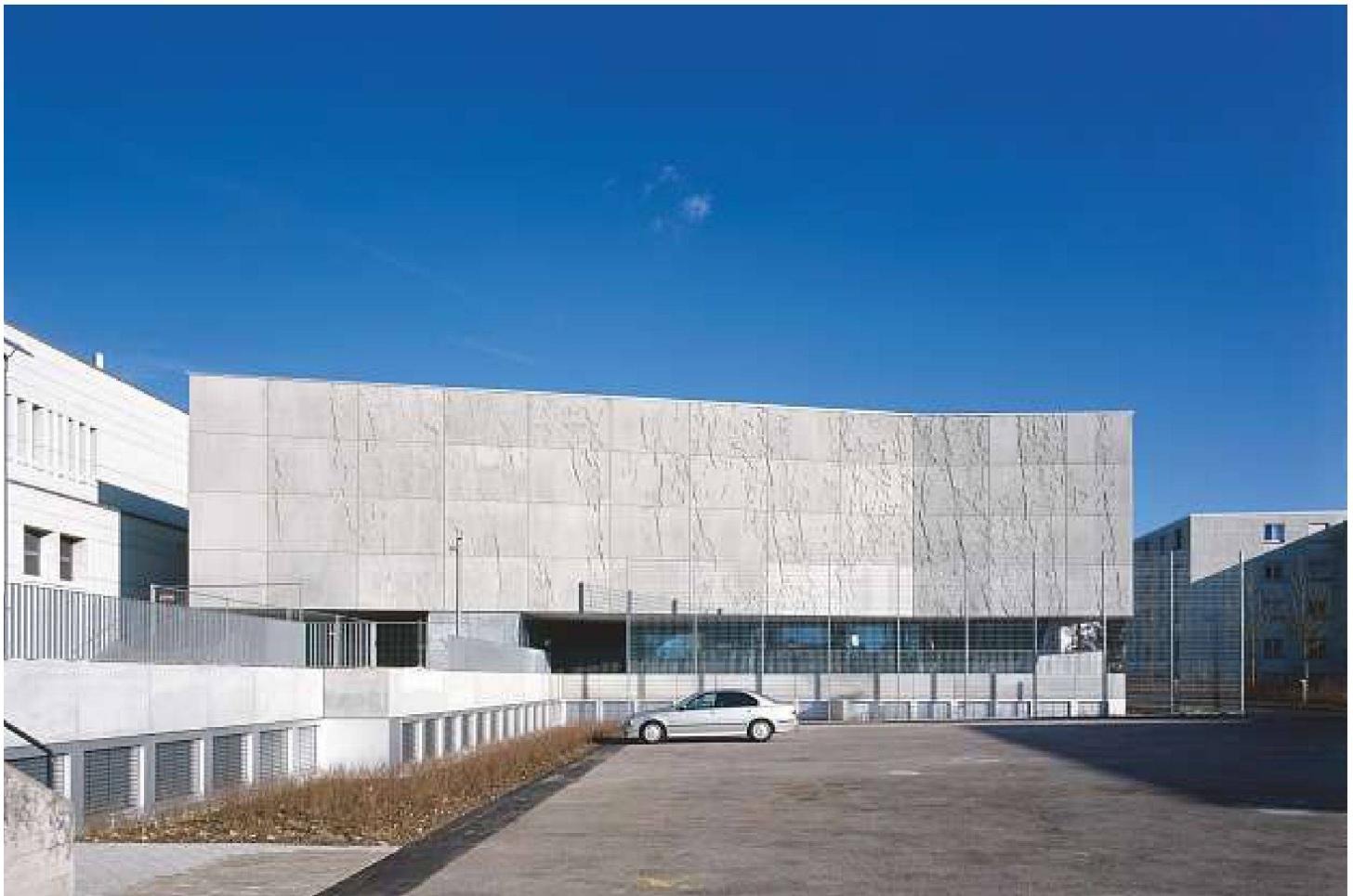
Ansicht von Osten. Der untere Pausenplatz dient bei öffentlicher Nutzung des Auditoriums als Parkplatz.
