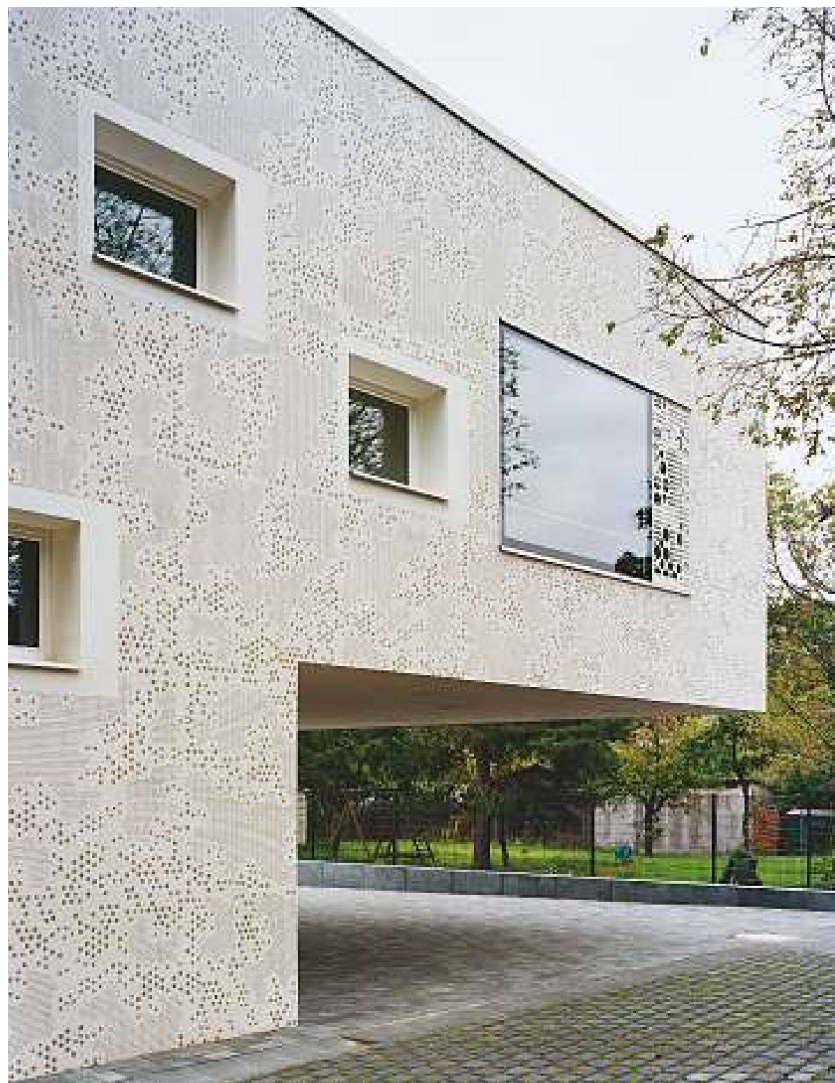
Grosse Fenster, dünne Rahmen, Lüftungsflügel mit weisser Blechverkleidung: Anna-Seghers-Schule in Berlin-Adlershof. – Bilder: Hans Christian Schink
