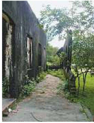
Ruine des Wohnhauses vor dem Umbau zur Kapelle. – Bild: Paulo Mendes da Rocha
