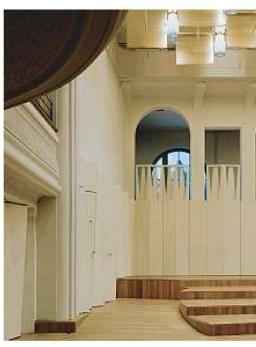
Diffraktor aus mit Gold belegten Sperrholzplatten (oben) und Täfelung zur Vermeidung von Flatterechos beim Bühnenbereich
