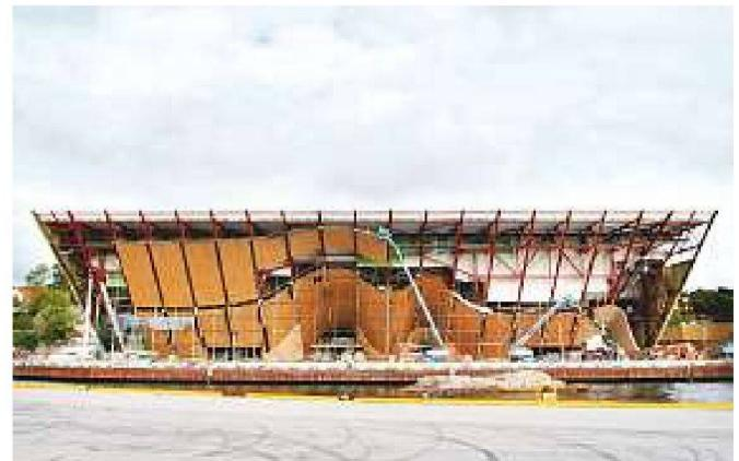
Bis auf diejenigen Fassadenelemente, die den Boden berühren, wurden alle vormontiert zur Baustelle verschifft und in das Stahlgerüst eingehängt – mit Montagefugen von nur 10 Millimetern bei einer ElementgröÙe bis zu 50 Quadratmetern. Damit die Befestigungspunkte zwischen Stahl und Holz erreichbar waren, wurde die Eichenschalung an den Rändern der Elemente erst nach der Montage
