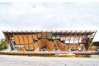
geschlossen. Am Ende laufen die 10 mm breiten Fugen zwischen den Eichenbrettern schnurgerade vom Boden bis zur Traufkante in 22 Meter Höhe durch. – Bilder: Trebyggeriet AS (oben, unten rechts), Thomas Unsheimo (unten links)
