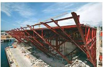
Bis auf diejenigen Fassadenelemente, die den Boden berühren, wurden alle vormontiert zur Baustelle verschifft und in das Stahlgerüst eingehängt – mit Montagefugen von nur 10 Millimetern bei einer Elementgrösse bis zu 50 Quadratmetern. Damit die Befestigungspunkte zwischen Stahl und Holz erreichbar waren, wurde die Eichenschalung an den Rändern der Elemente erst nach der Montage
