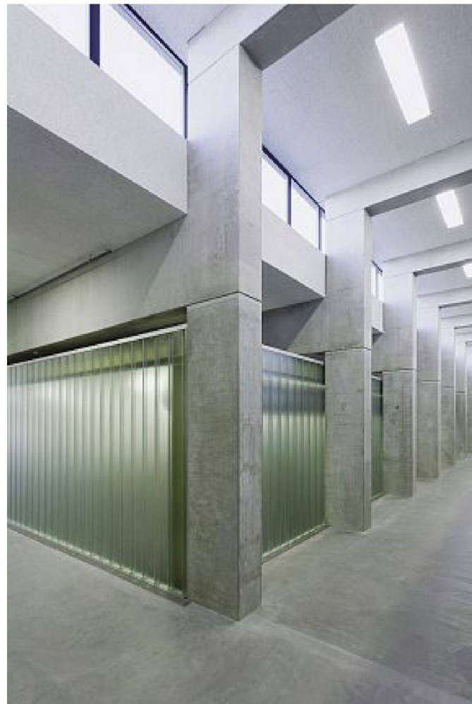
Erschliessungszone im Erdgeschoss mit provisorischen Einbauten.
