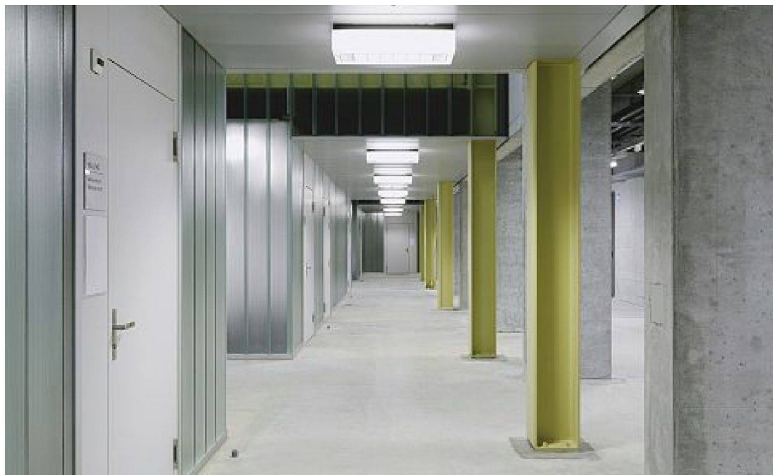
Stahl und Profilit kennzeichnen die Einbauten im Untergeschoss
