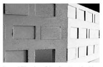
Betonmodell Fassadenstudie Brandhaus. Vor- und zurückspringende Wandfelder versteifen die freistehenden Betonfassaden und deuten zugleich Fenster als Referenzpunkte zur Orientierung an. – Bild: ARCHITEKTUR WERK und Atelier M Architekten
