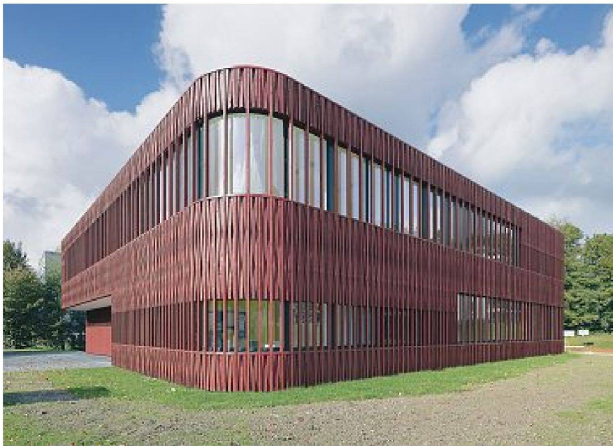
Schulhaus Büttenen, Luzern: Präsenz markieren im Wohnquartier
