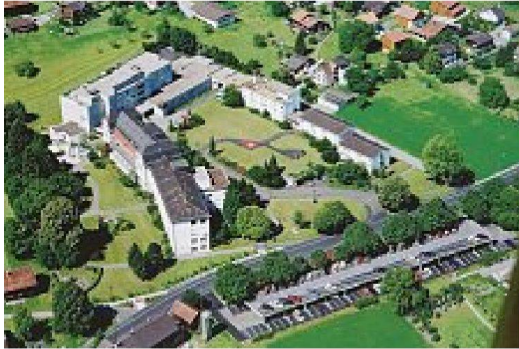
Kantonsspital Grabs: bestehende Anlage
