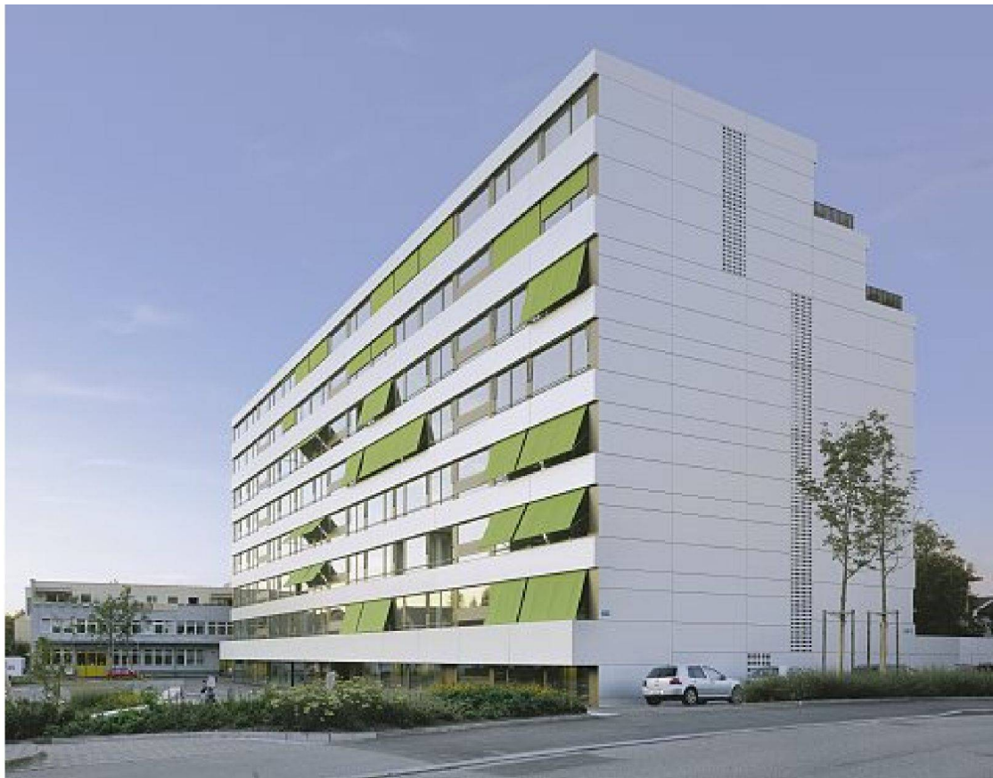
Wohnhaus mit Aluminiumverkleidung, Ansicht von Süden
