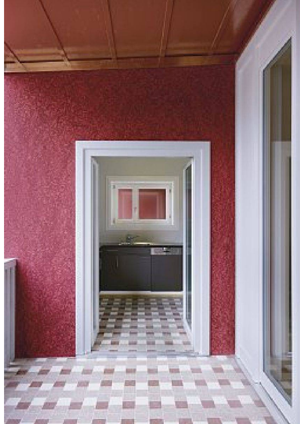
Terrasse und Blick in die Küche einer Wohnung im Obergeschoss
