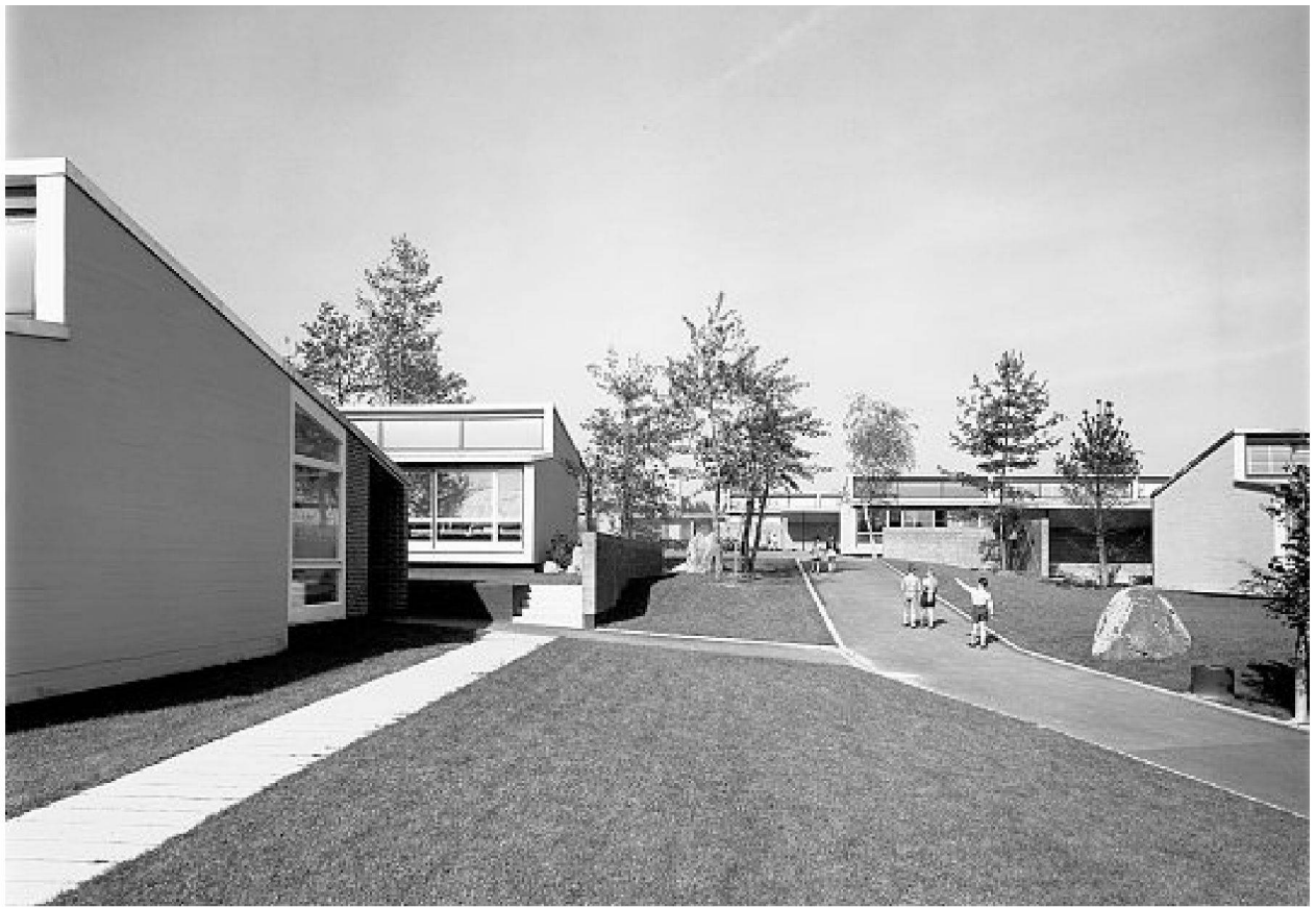
Primarschulhaus Chriesiweg in Zürich-Altstetten von Cramer Jaray Paillard (1957). – Bilder: Baugeschichtliches Archiv Zürich
