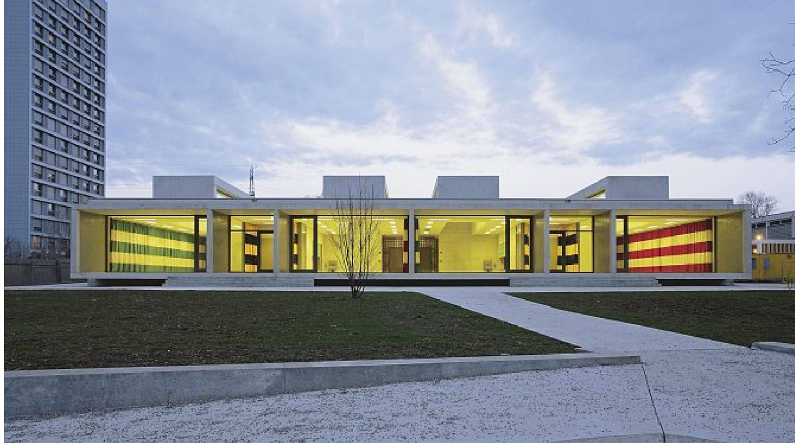
Schulhaus Hirzenbach in Zürich-Schwamendingen von Adolf Wasserfallen (1955–1965), 2006 von Boltshauser Architekten mit Kindergarten, Hort und Turnhalle erweitert. – Bild: Beat Bühler
