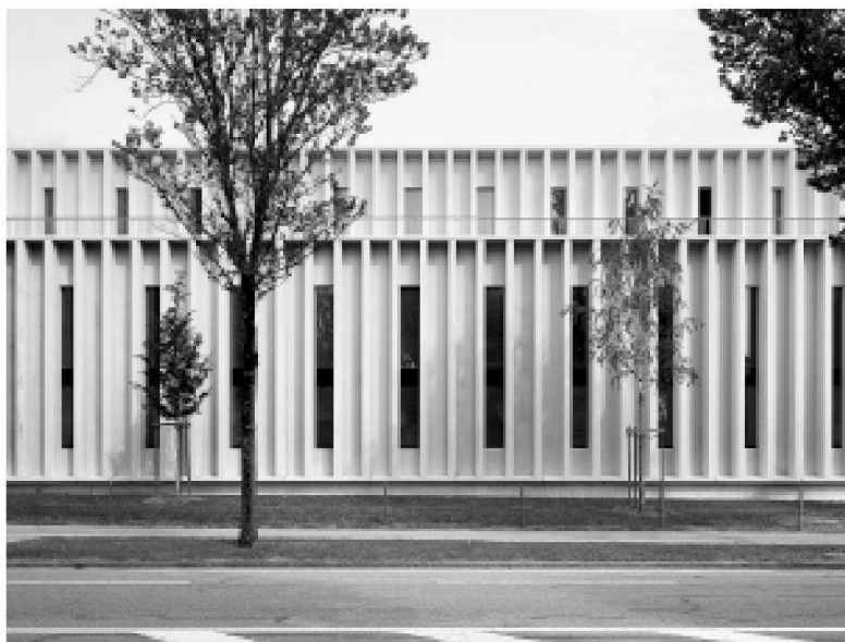
Längsfassade aus vorfabrizierten Betonelementen entlang der Portstrasse
