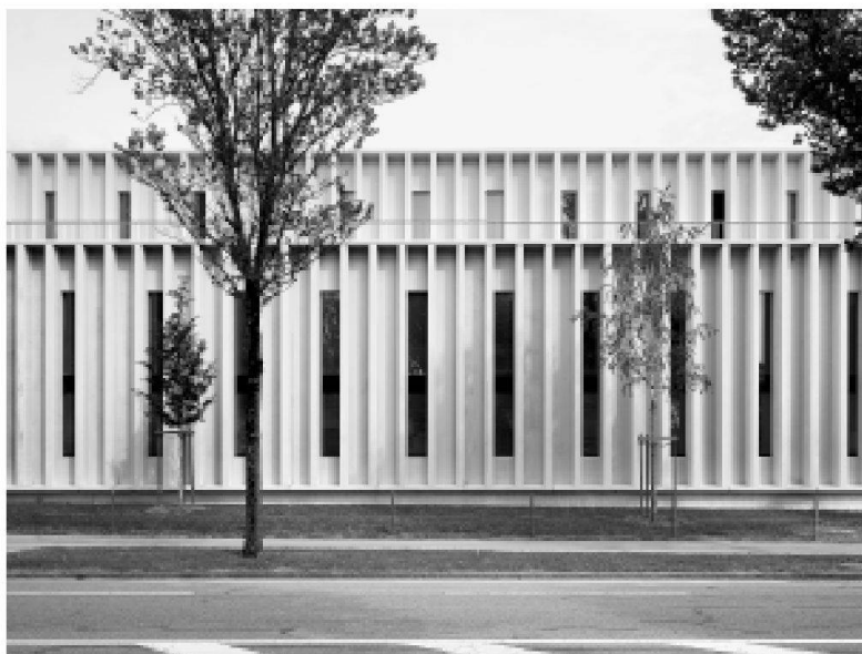
Längsfassade aus vorfabrizierten Betonelementen entlang der Portstrasse
